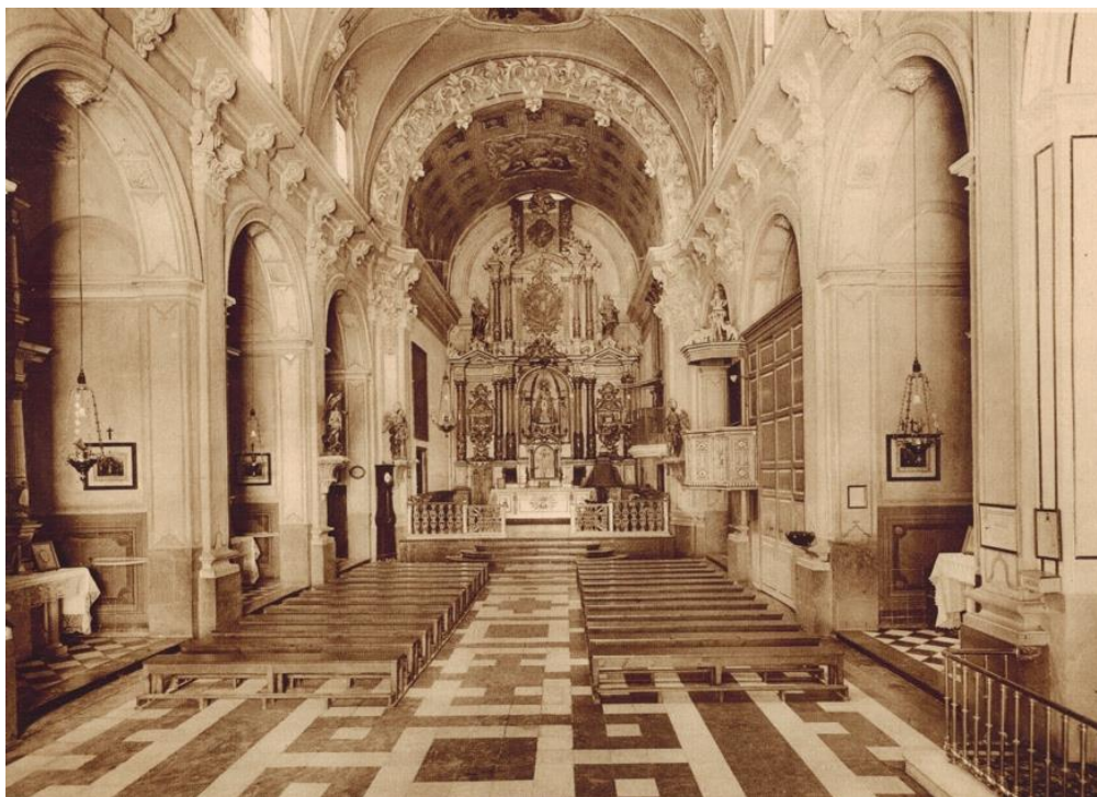
Fig. 1: Interior de la iglesia. Hospital General (1927) de Vicente Barberà Masip. (Archivo personal del autor).
