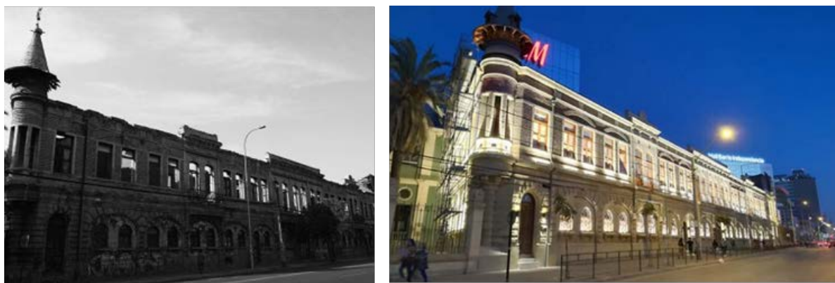
Figuras 9a y 9b. Edificio de la antigua cervecería de Andrés Ebner, en el cordón industrial de la comuna de Independencia y actual “Mall Independencia”
