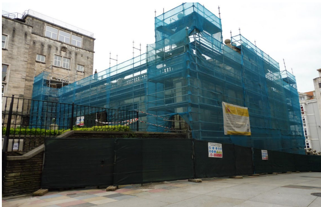
Figura 1. El edificio en obras
